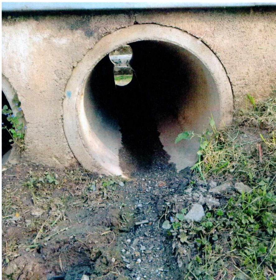
Poměrně ilustrativní obrázek vypovídající o obráceném sklonu propustku
